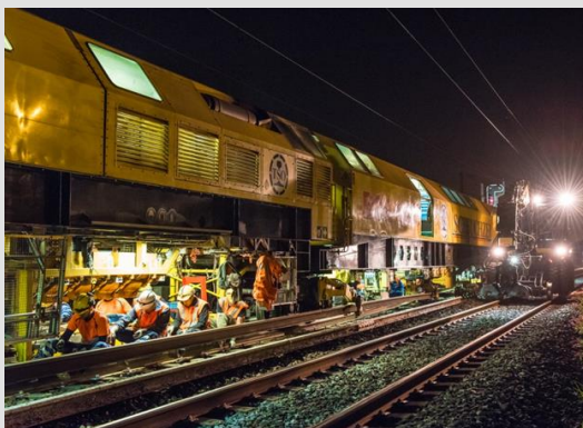
Renouvellement de rails à l'aide du train BOA
