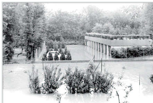
Figure 15 : Inondations devant la gare de Bièvres (source : Association « Les amis de la Bièvre »)
