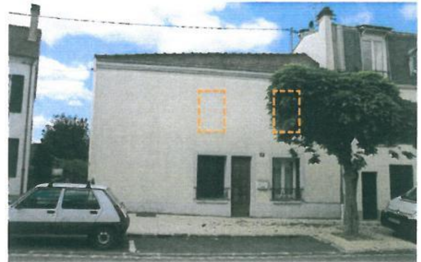
Ce genre de façade peut accueillir sans problème de nouvelles ouvertures qui pourront être alignées avec les baies existantes du rez-de-chaussée
