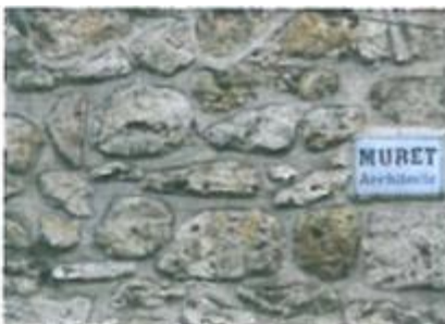
Moellons de meulière appareillés en opus, incertum à joints larges et creux
