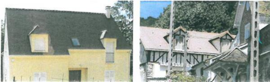
Lucarnes engagées dans les murs, « à la capucine » maçonnées
