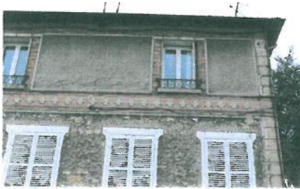
Les décors de brique et de pierre ainsi que le mélange des parements contribuent à la richesse de cette façade
