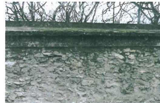
Mur de clôture maçonné
