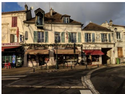
Toiture en pavillon en tuiles plates
