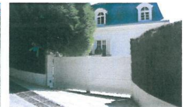
Portail en PVC à proscrire, il est inadapté au site classé.
