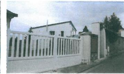
Portails intéressants : il est nécessaire de faire attention au traitement des maçonneries des piliers
