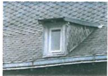
Coyau et lucarne sur le versant, rampante, charpentée
