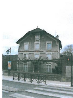
Toiture à demi-croupe en ardoise
