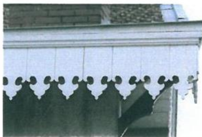
Le lambrequin en bois découpé masque le débord de toit en bois et souligne l'égout
