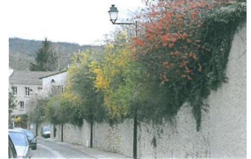
Sujets arbustifs remarquables associés à un mur maçonné
