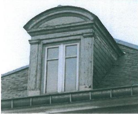
Lucarne charpentée fronton positionnée sur le versant
