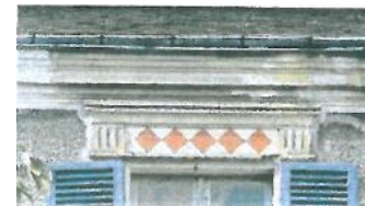
Corniche moulure plâtre. Linteau de baie ornementé. Incrustation de carreaux de terre cuite et grès
