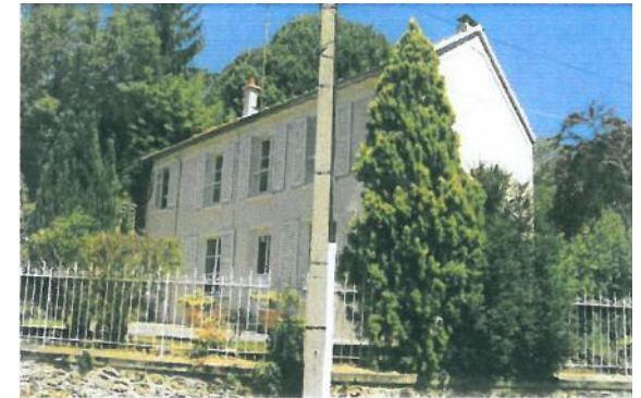
Sur le bâti ancien les enduits à base de chaux sont techniquement et esthétiquement les plus performants
