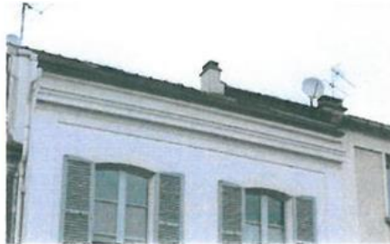
Corniche en pierre
