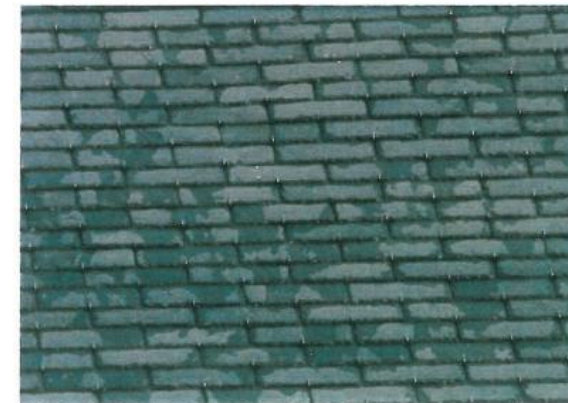
Tuiles mécaniques à emboîtement en terre cuite
