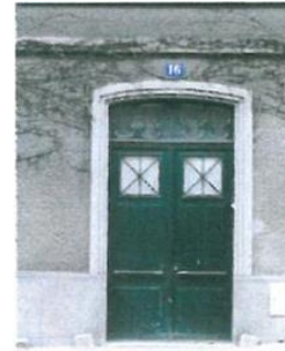
Porte d'entrée à deux vantaux et imposte fixe vitrée
