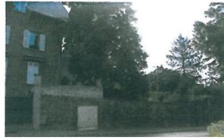
Mur de clôture maçonné construit dans le même matériau que le bâtiment
