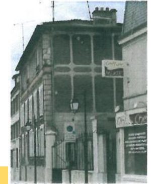
Exemple d'enduit dit "à la tyrolienne"
