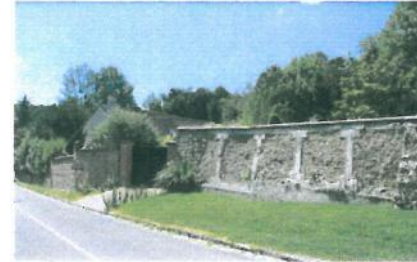
Mur de clôture maçonné en meulière et pierre de taille
