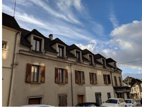
Lucarnes engagées dans le mur, « à la capucine », maçonnées
