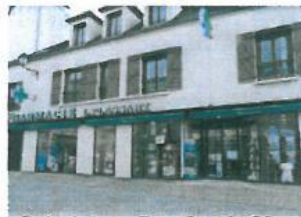
Linéaire vitré trop important
