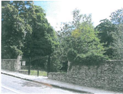
La clôture est un élément structurant non seulement avec la parcelle et le bâti mais aussi avec le paysage avec lequel elle doit s'accorder. Elle est le révélateur du découpage foncier et forme un tout avec le bâti
