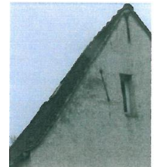
Rive de toit dans l'alignement du mur pignon
