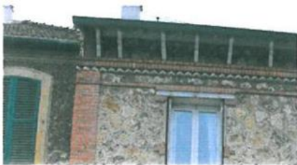
Déborder de toit en bois
