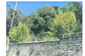
Mur de clôture maçonné
