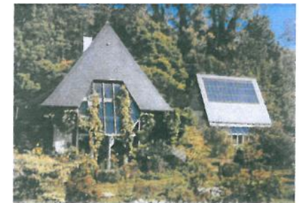
Exemple réussi d'intégration de capteurs solaires, extrait du livre « Une maison plus saine »
