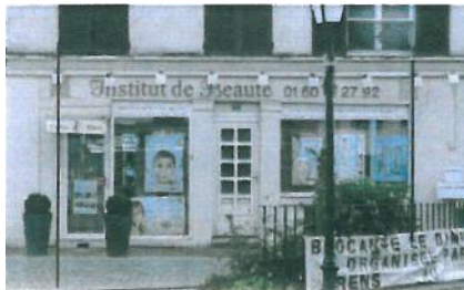
Les ouvertures sur rez-de-chaussée devraient être symétriques par rapport à la porte d'entrée du bâtiment (dans la forme et la partition) pour une meilleure intégration
