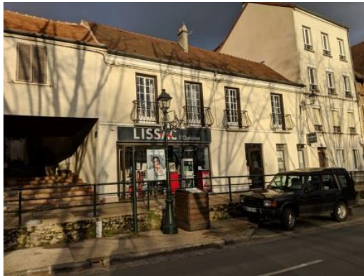
Toiture à deux pentes, en tuiles plates et faitage à embarrures
