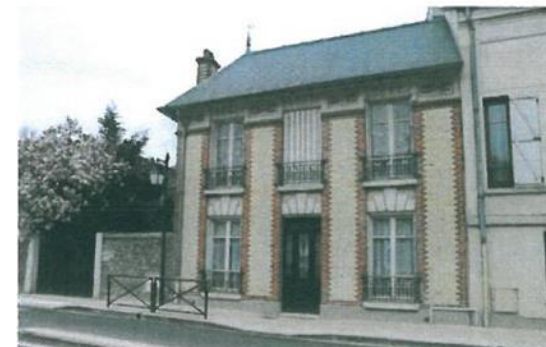
Façade en briques rouge et jaune et en pierres de taille. C'est une des rares façades où la brique domine
