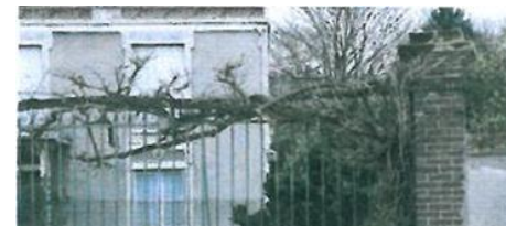
Pilier en brique, grille en fer forgé sur mur bahut, glycine
