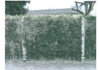
Clôture en grillage et pilier béton, haie vive. Pour que le végétal soit mis en valeur peindre l'ensemble (grillage et piquets) de couleur vert foncé et préférer des piquets métalliques moins visibles
