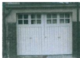
Porte de garage en bois plutôt bien intégrée au bâti
