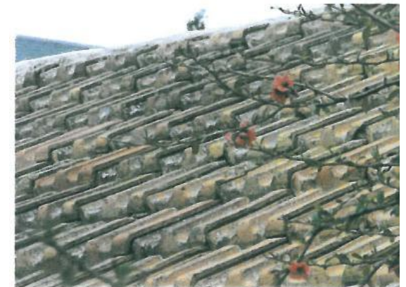
Tuiles mécaniques à emboîtement en terre cuite
