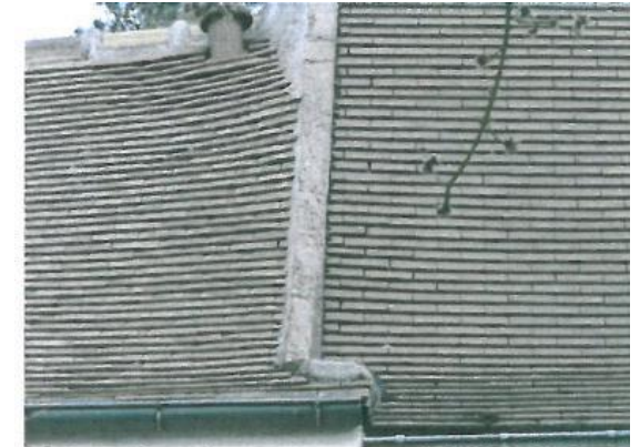
Toitures terre cuite en tuiles plates petit moule
