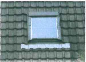
Exemple de châssis de toit : pour une meilleure intégration, il doit être encastré
