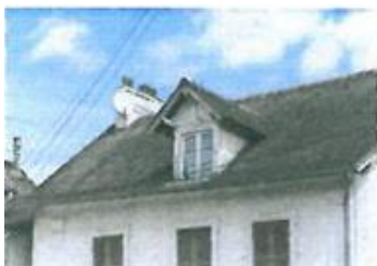
Lucarne engagée dans le mur, en bâtière, maçonnée
