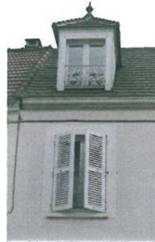
Lucarne sur le versant, "à la capucine" charpentée, axer sur la fenêtre de l'étage
