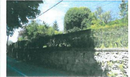
Mur de clôture servant de mur de soutènement surmontée d'un grillage et d'une haie
