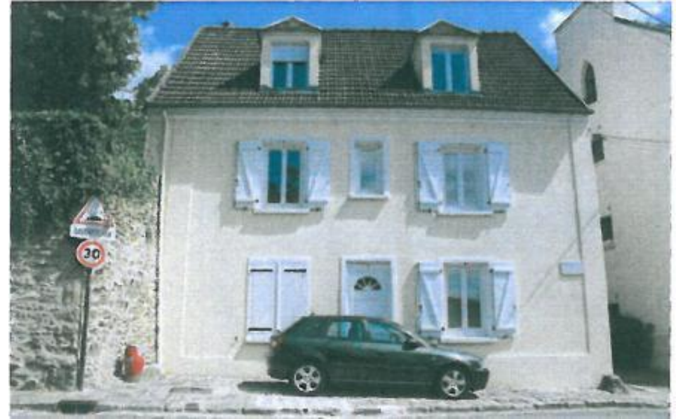
L'emploi de menuiseries en PVC a considérablement appauvri cette façade : épaisses et larges l'éclairage et réduit et la proportion des baies modifiée. D'autres éléments contribuent à cet appauvrissement, notamment les contrevents et l'enduit monocouche qui masquent les éléments de modénature
