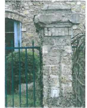
Piliers en moellons de meulière taillés appareillés à assises régulières
