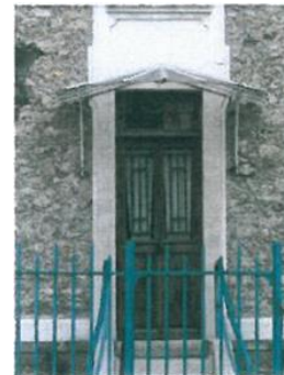
Porte d'entrée vitrée à un vantail. Imposte vitrée - Marquise en verre
