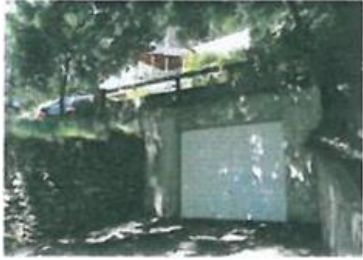
Sur ces deux images les garages sont le premier élément que l'on appréhende en arrivant sur la parcelle, très présent, il s'intègre mal à l'environnement non seulement bâti mais aussi végétal
