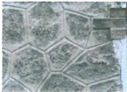
Appareil de meulière en mosaïque et joints creux tirés au fer
