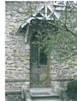
Porte vitrée à un vantail en arc cintré - Marquise charpentée
