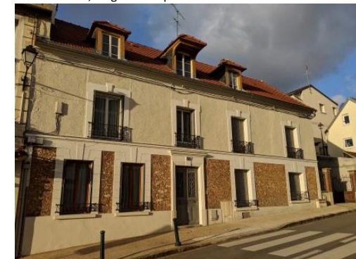
Lucarnes sur le versant, "à la capucine", charpentée et axée sur les baies de l'étage. La lucarne centrale est, en plus, à croupe débordante (pour fixer une poulie ou un crochet)
