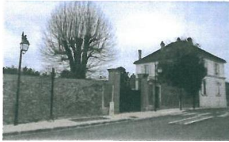
Mur de clôture maçonné
