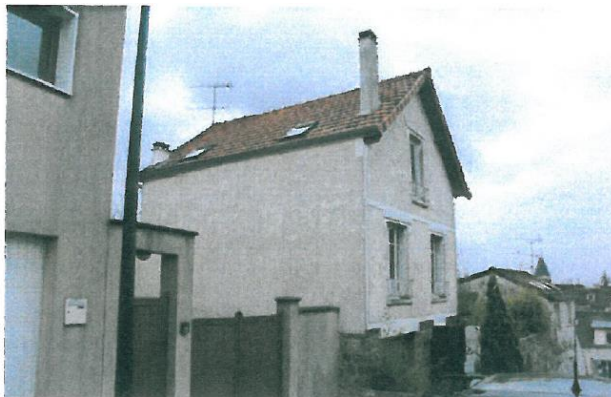
Toiture à deux pentes en tuiles mécaniques avec débordement en pignon
