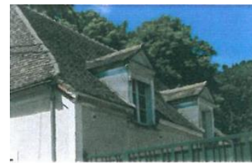
Lucarnes engagées dans le mur, à fronton, maçonnées
